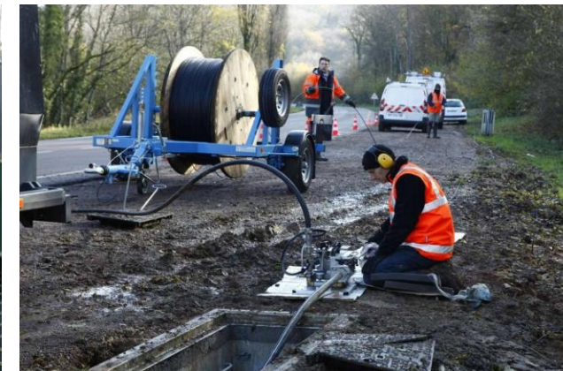
Fibre optique : 25 milliards d'euros d'installation
